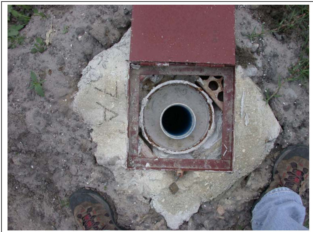
Detalle del estado final del sondeo
