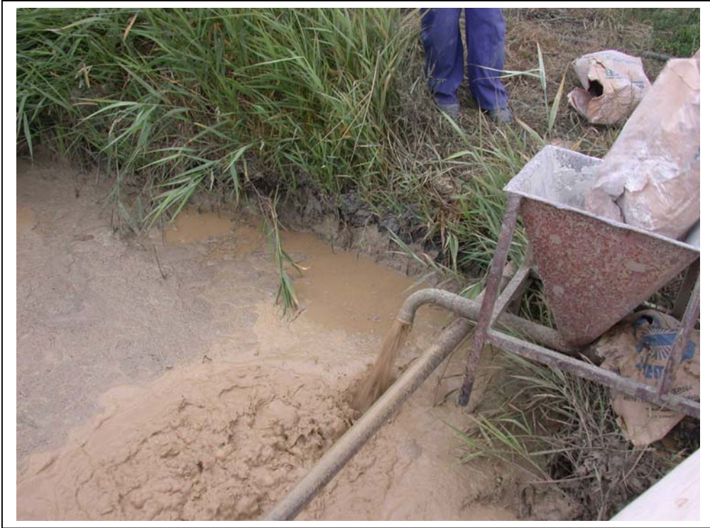
Detalle de la elaboración de lodo para la perforación
