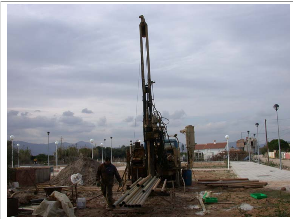
Labores de perforación
