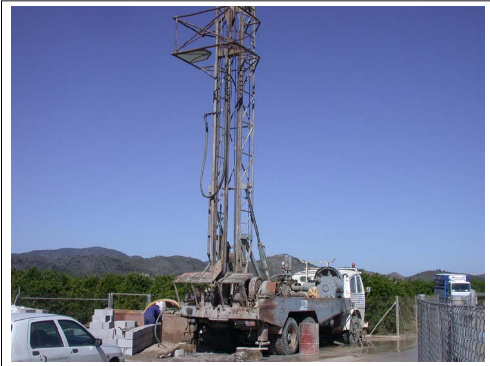
Labores de perforación
