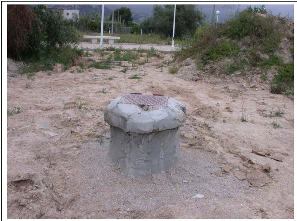
Detalle del estado final del sondeo
