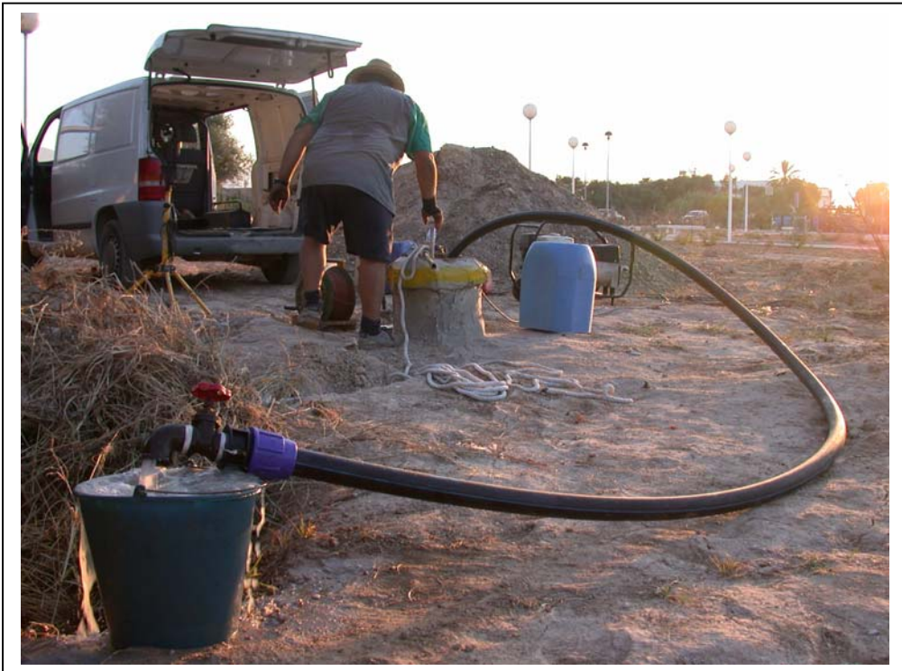
Prueba de bombeo
