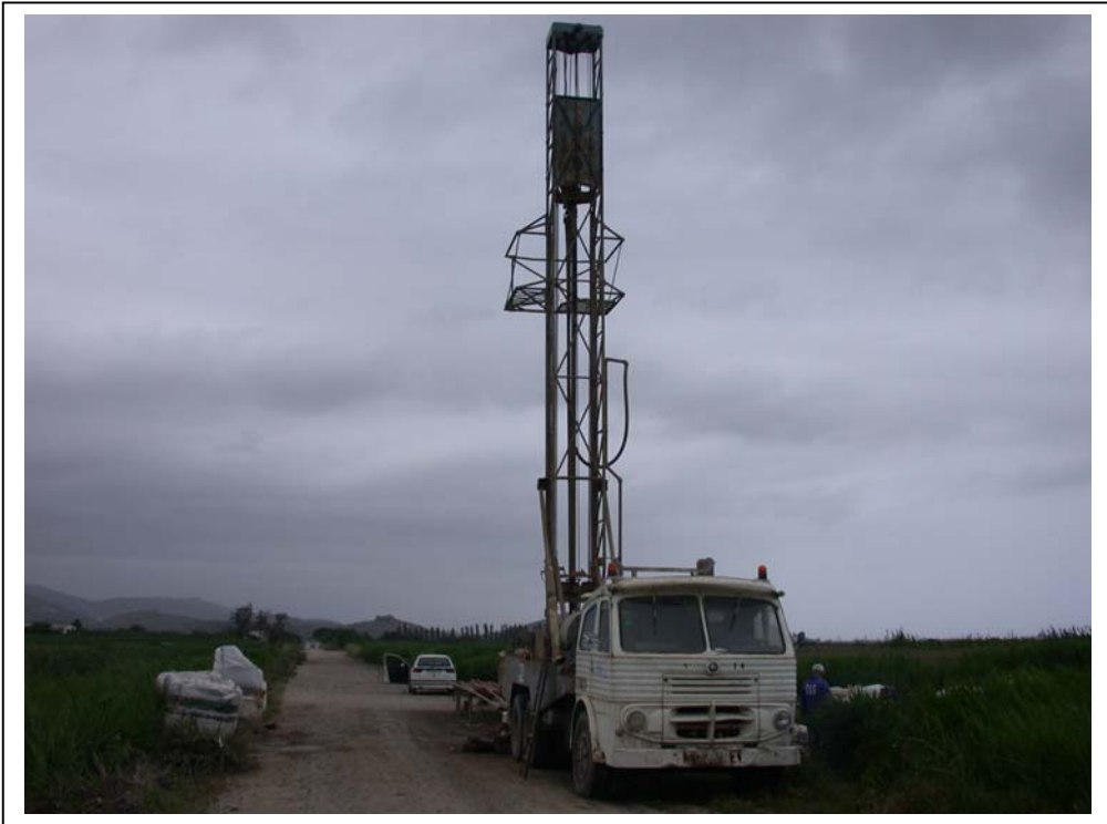
Vista del emplazamiento definitivo de los sondeos PDGEST-6b y 6c
