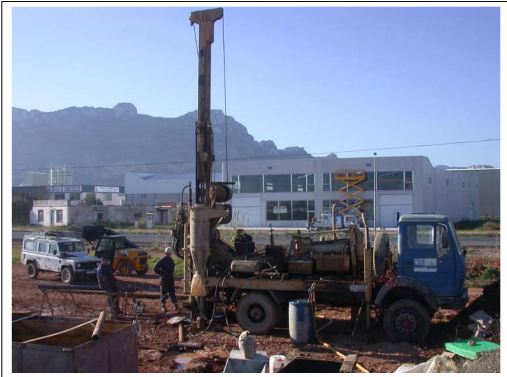
Vista general de la máquina de perforación
