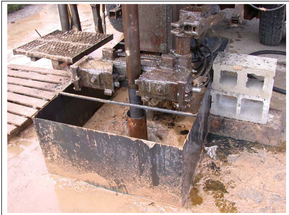
Detalle de las labores de perforación
