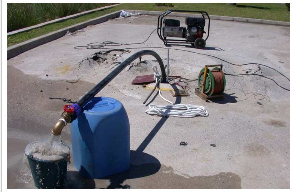
Prueba de bombeo
