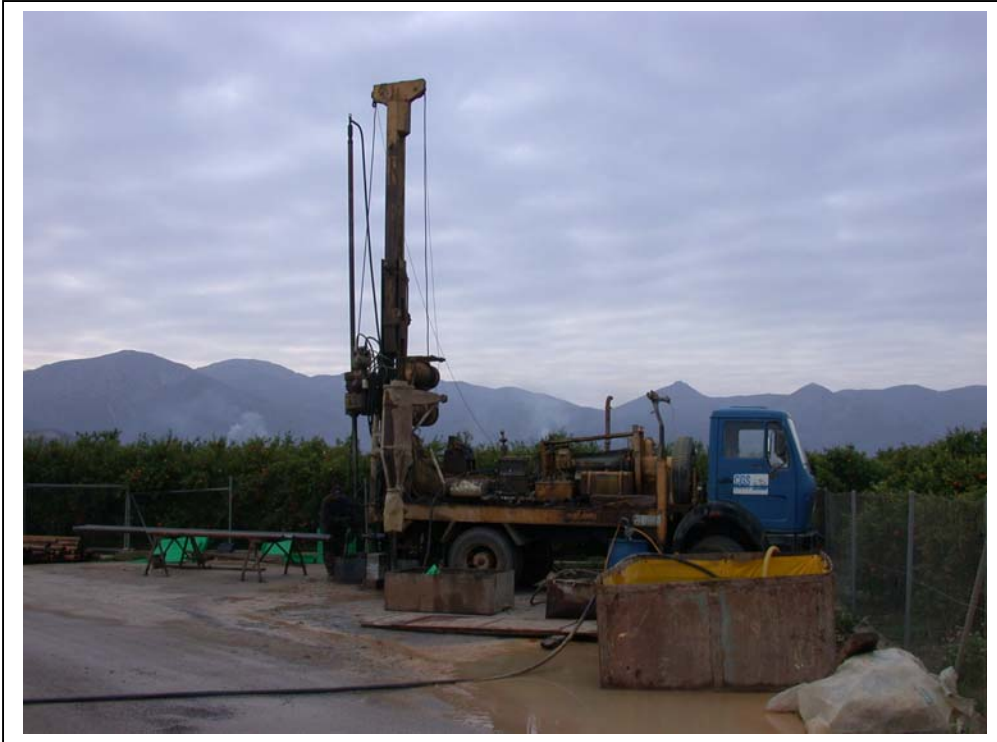
Ejecución del sondeo PDGEST-5a
