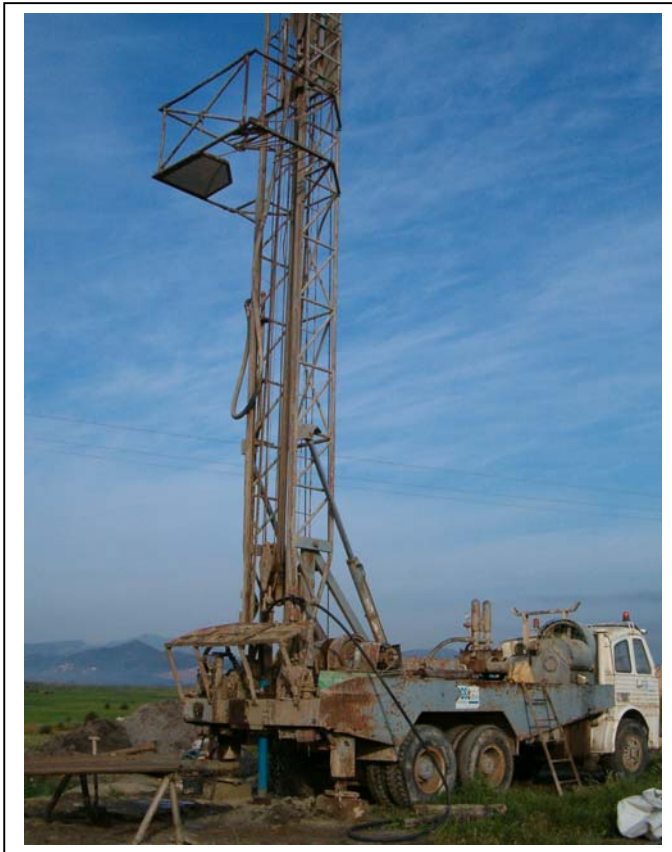
Detalle de la máquina de perforación
