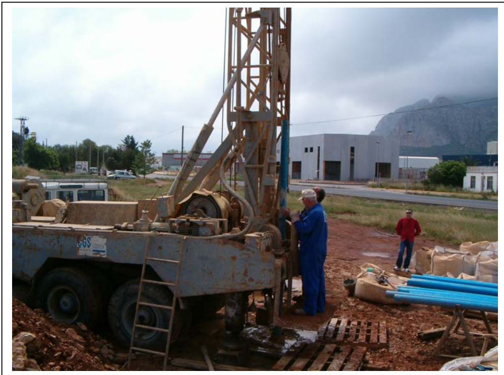
Entubación del sondeo
